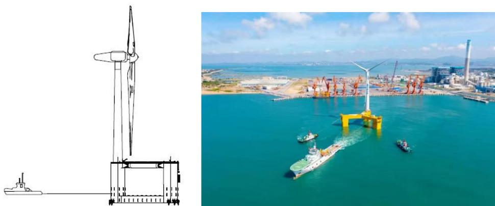
图7-3 浮式风电机组湿拖过程中
