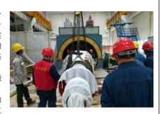
合作,有条不紊,不断调整转子的穿入量和中心位置,确保调相机转子始终保持平稳状态。调相机转子在起重人员指挥下缓缓吊起,缓慢移动到调相机定子处。在调相机厂厂代指导下,起重人员、安装人员不断调整转子的穿入量和中心位置,整个穿入过程转子无一处碰撞、刮伤。经过全体作业人员的共同努力,于17时36分高标准一次完成了转子穿装工作,得到了业主、监理的一致好评。(童鹏程 陈光涛 严远丹)
