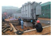
11月19日,由湖南火电电网工程公司 承建的江西金华山升压站110kV主变安装 就位,顺利实现了江西大唐石城金华山风 电场升压站工程建设的首个重要节点目标
